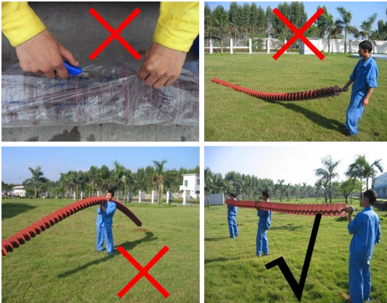
图 6：复合绝缘子安装注意事项
